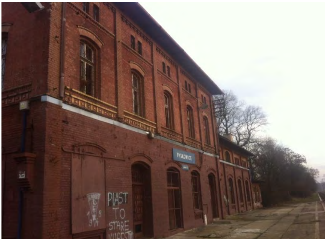
Rysunek 11. Dworzec kolejowy stan obecny
