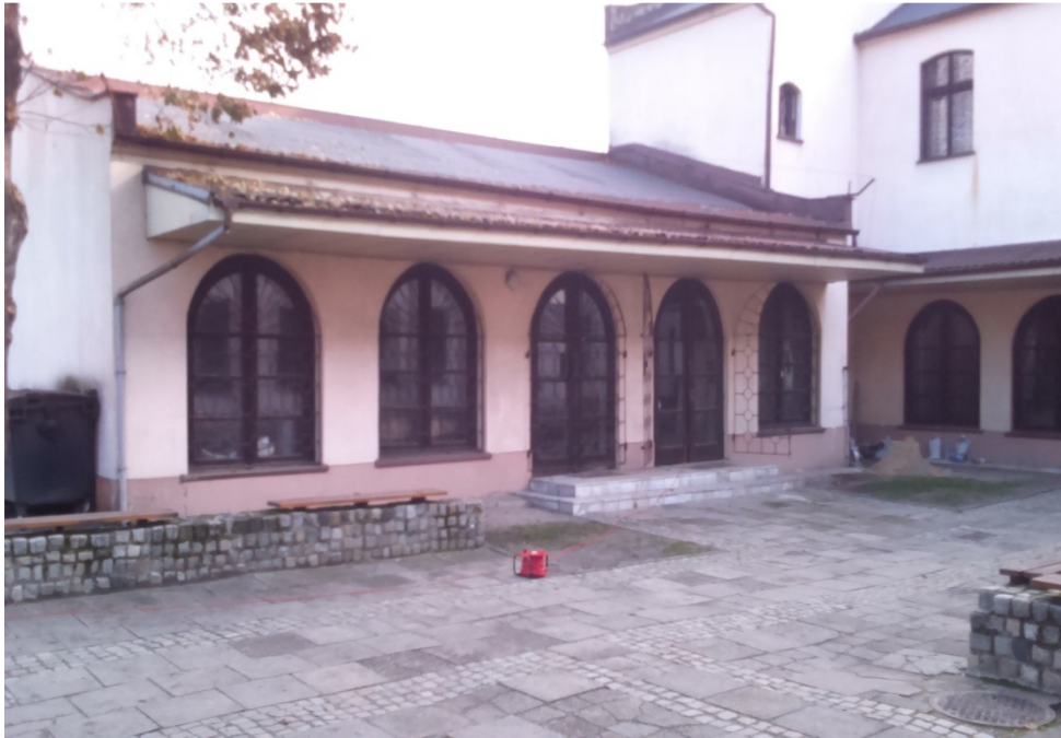
rysunek nr 3 . widok na jednokondygnacyjne skrzydło budynku - od strony dziedzińca.
